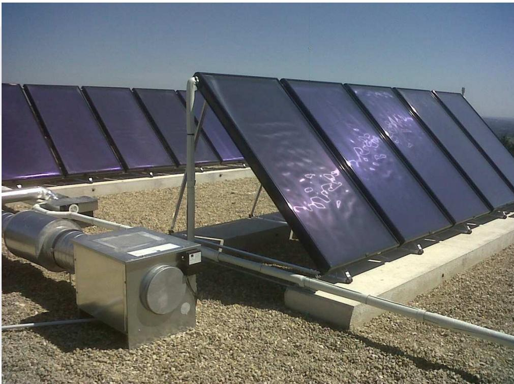
Les capteurs solaires thermiques sont destinés à capter le rayonnement solaire pour chauffer un fluide caloporteur. La chaleur véhiculée par ce fluide est ensuite utilisée dans le bâtiment, via un échangeur thermique, soit pour produire de l'eau chaude sanitaire ou du chauffage.
